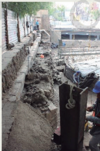
Vistas de este a oeste y de oeste a este del corte norte de la banqueteta de la Avenida Flores Magón. Se aprecian los encofrados de concreto de TELMEX que descansan sobre inmuebles prehispánicos
